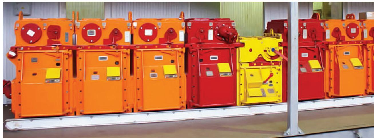
Распределительный пункт на базе КАВ 6 кВ сейчас работает в модульном здании на шахте «Талдинская–Западная–1»
