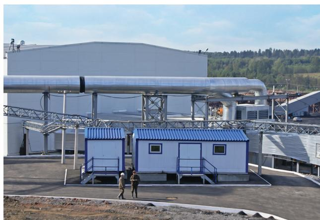
На шахте «Талдинская–Западная–1» в малом модульном здании располагаются компенсаторы реактивной мощности (КРМ), а в большом размещен распределительный пункт 6 кВ
